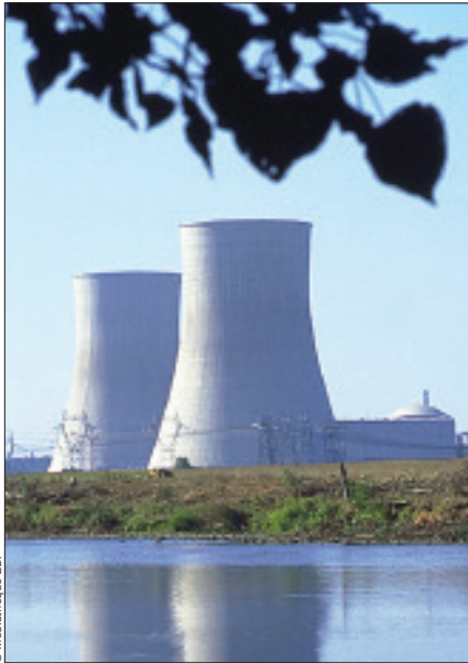
La centrale nucléaire de Civaux (Vienne).
