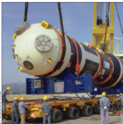
Transport d'un générateur de vapeur.
