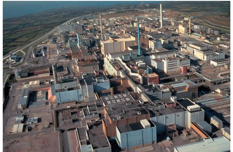
Fig. 14. L'usine de retraitement de COGEMA La Hague (Manche), dans laquelle sont réalisées les opérations de traitement du combustible et de conditionnement des déchets.
