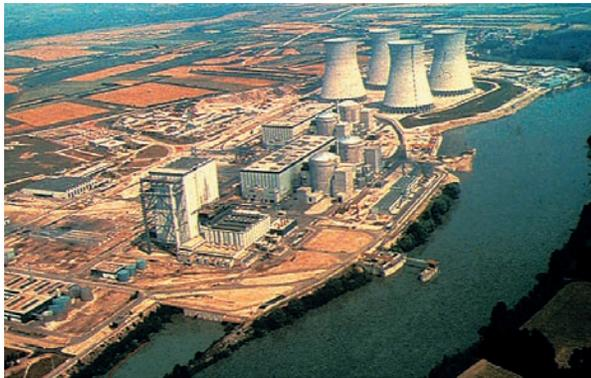
Fig.85. Des réacteurs de 1<sup>re</sup> génération à ceux de 2<sup>e</sup> génération : on voit le gros réacteur UNGG (arrêté) et les petits REP (en service) qui lui ont succédé sur le site du Bugey (Ain).
